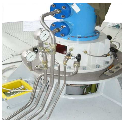
Hydraulický agregát pro regulaci Kaplanovy turbíny Hradištko – ČR.
